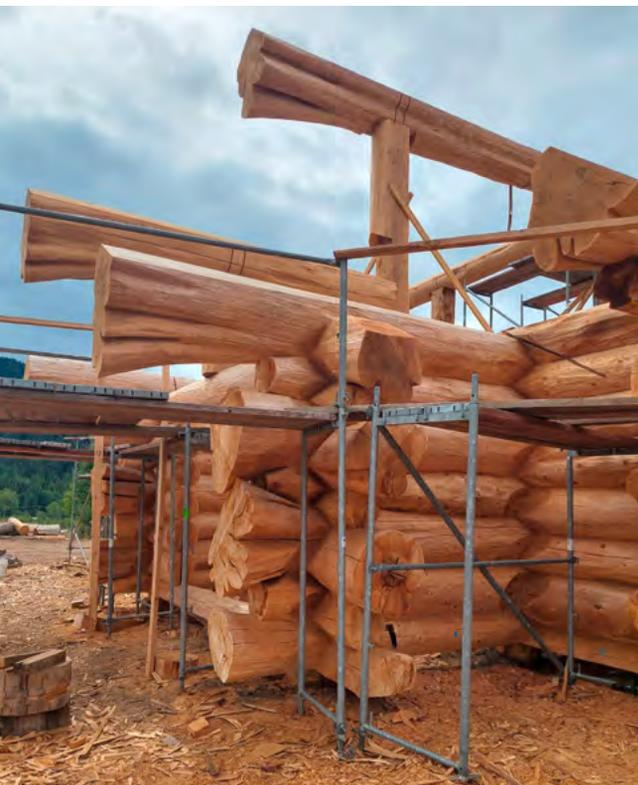
Die horizontal aufeinander gefügten Balkenreihen schrumpfen durch Nachtrocknung und nachträgliche Verdichtung im Balkengefüge in der Wandhöhe etwas zusammen. Dadurch schwindet jeder einzelne Balken um etwa 1–2 mm, somit «setzt» sich das ganze Haus.
